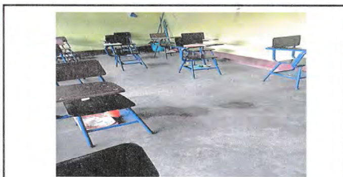
Foto 5: Piso de concreto en mal estado con picaduras en cinco salones de clase de 48 metros cuadrados y una bodega de 12 metros cuadrados, se puede observar que se está rajando.
