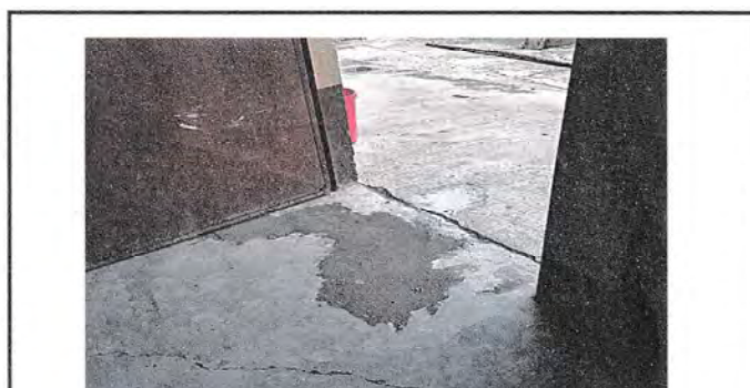
Foto 6: Se encuentra el piso de concreto gretado y con elevaciones anormales en cinco salones de clases de 48 metros cuadrados y una bodega de 12 metros cuadrados.
